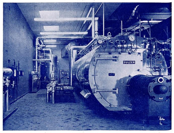
Heißwasseranlage in einer Färberei mit Sulzer-Dreizugkessel
