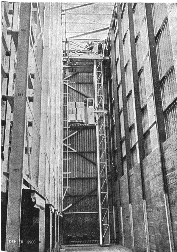
Der Stapelkran beim Einlagern einer Palette vor der Einfahrt in den Längsgang
