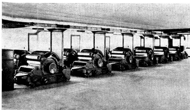
Karderie mit Rieter Karden C 1 und Aerofeed-Anlage mit Speiseschächten zu den einzelnen Karden
