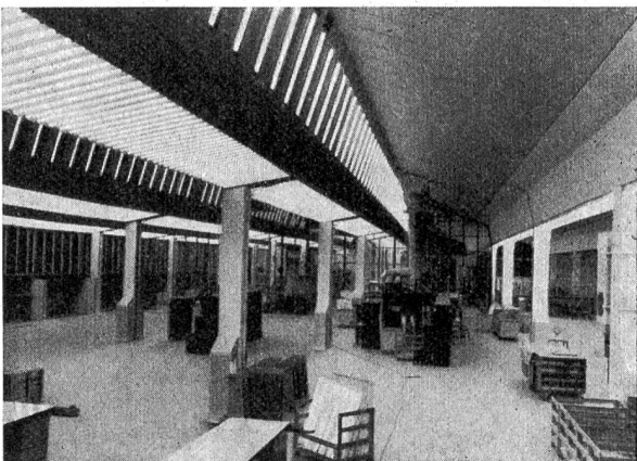
Fig. 7 Teilansicht einer Shed-Fabrikationshalle mit Blick auf die Fensterflächen. Die Beleuchtungsstärke beträgt über 1000 Lux
