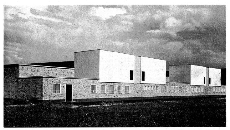
Abb. 5: Außenaufnahme einer fensterlosen Spinnerei. Nur die Nebenräume, welche unter den Klimazentralen liegen, haben Fenster
