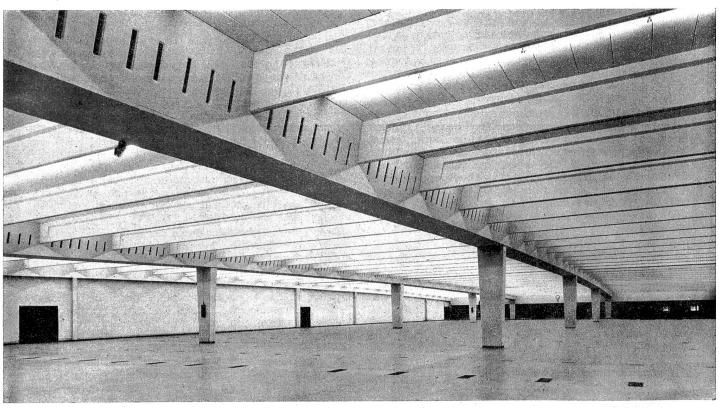
Abb. 4: Innenaufnahme eines fensterlosen Spinnereisaales mit Klimakanalträger (System Gherzi). Durch Gitter abgedeckte Rückluftöffnungen im Boden. Die künstliche Beleuchtung ist blendungsfrei zwischen den Sekundärträgern angeordnet
