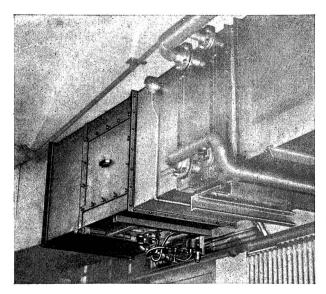
Teilansicht eines Lüftungskanals mit eingebauter Vernebelungsturbine
