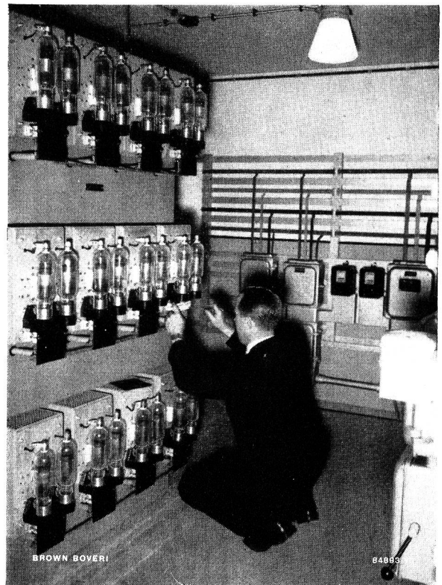
50-kW-Schneisenbeleuchtungsanlage im Flughafen Schiphol (Holland). Mit 12 Thyralux-Geräten, vier je Phase, wird die dreiphasige Anlage stufenlos und trägeheitslos gesteuert.
