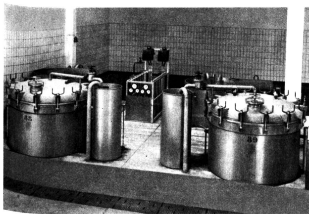
Gekuppelte Kreuzspulfärbeanlage mit einem Fassungsvermögen von ca. 300—500 kg, gekuppelt also 600—1000 kg, je nach Material und Farbstoffklasse Scholl AG., Zofingen/AG
