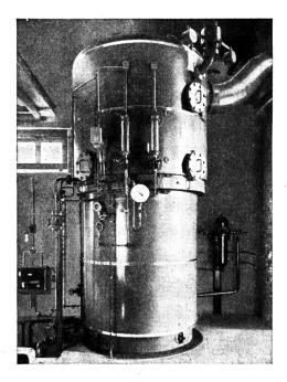
Fig. 1 Feuerbüchs-Röhren-Dampfkessel
