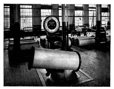
Toledo-Waage in der Zettlerei.
