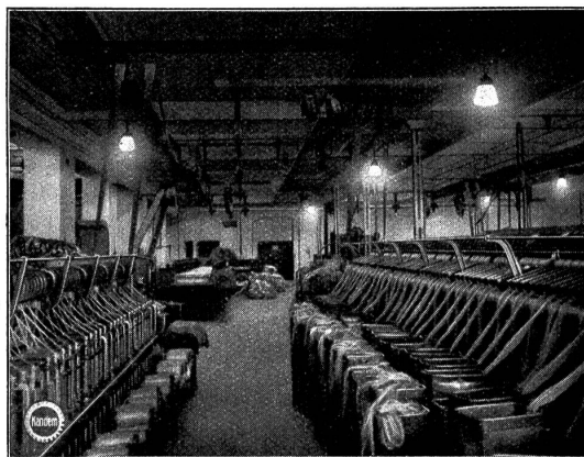
Abb. 5. Vorbildliche Beleuchtung durch staubdichte Kandem-Leuchten für vorwiegend tiefstrahlendes Licht.
