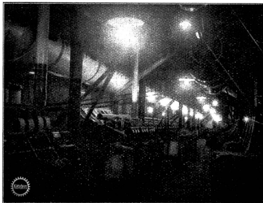
Abb. 4. Schlecht beleuchtete Flachsstrecke mit veralteter, unzweckmäßiger Beleuchtung (Blendung — Unübersichtlichkeit).
