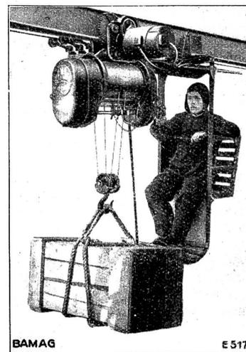
2. Zur Bedienung auf unübersichtlichen, ausgedehnten Arbeitsplätzen wird der Elektro-Flaschenzug mit Führersitz verwendet. Außerordentlich geringes Eigengewicht und große Tragfähigkeit zeichnen dieses nützliche Fördermittel besonders aus.
