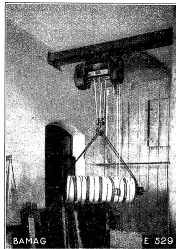
1. Elektro-Flaschenzüge kennzeichnen eine wirtschaftliche Fließfertigung. Transport eines schweren Kettbaumes mit einem Elektroflaschenzug.
