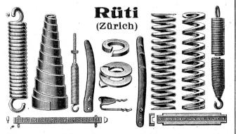
Spiral-, Zug- und Stossfedern von 0,3 bis 35 mm Stahlstärke, in rundem und vierkantigem Draht, aus feinstem Stahldraht, wie auch aus Messing und Neusilber.
