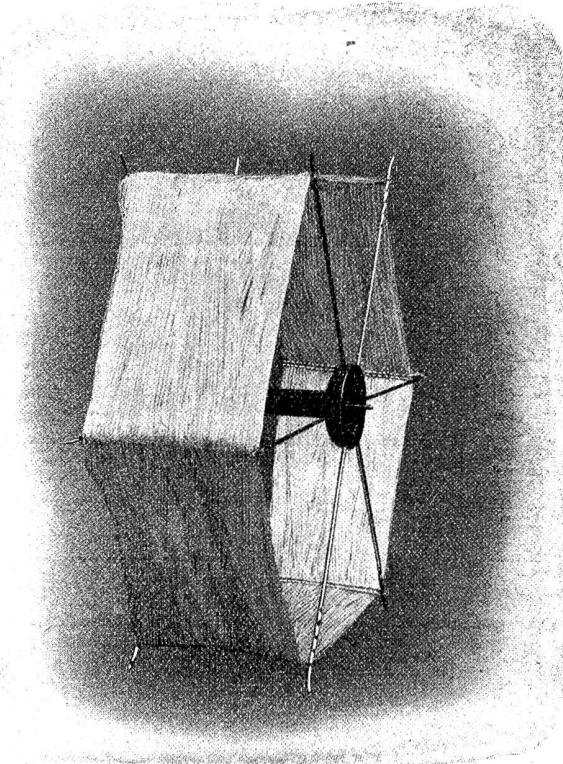
**„Elastic“ montiert.** Kein Brechen der Seitenstäbchen mehr. Höchst **elastische** Auflage für das Material, da die seitlichen **Stahlstäbchen** beim geringsten Zerren des ablaufenden Fadens federnd nachgeben, d. h. sich einbiegen, sodass sich der Faden meist selbst lösen kann, ohne zu zerreißen.
