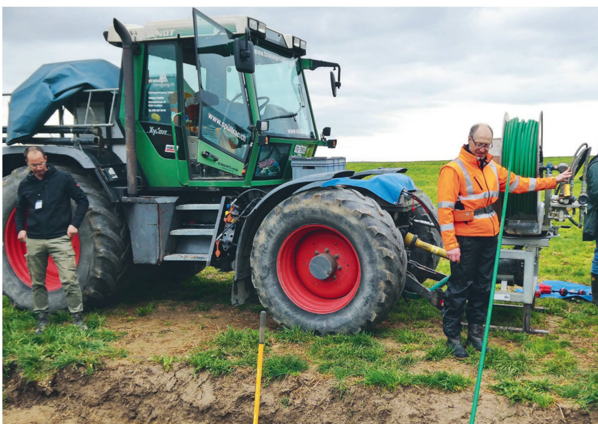
Les drainages ont besoin d'entretien; ils peuvent être curés et retrouvent ensuite intégralement leur fonction.
