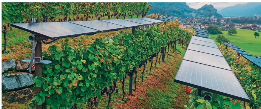
En Suisse, l'agrivoltaïsme n'en est qu'à ses balbutiements. L'installation représentée ci-dessus a été montée par des particuliers dans un vignoble de Walenstadt (SG). Les vignes se trouvant sous les modules solaires sont moins sujettes aux maladies foliaires. Comme les modules sont installés suffisamment au-dessus des plantes, la production d'électricité n'entraîne ici pas de perte de rendement. Photo: Peter Schumacher/ZHAW
