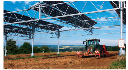
Installation photovoltaïque pilote de l'Institut Fraunhofer ISE, à Heggelbach dans l'Allgäu (sud-ouest de la Souabe, en Allemagne). Les modules solaires sont disposés en hauteur. Ainsi, le tracteur peut passer dessous pour effectuer les travaux nécessaires dans les cultures.
