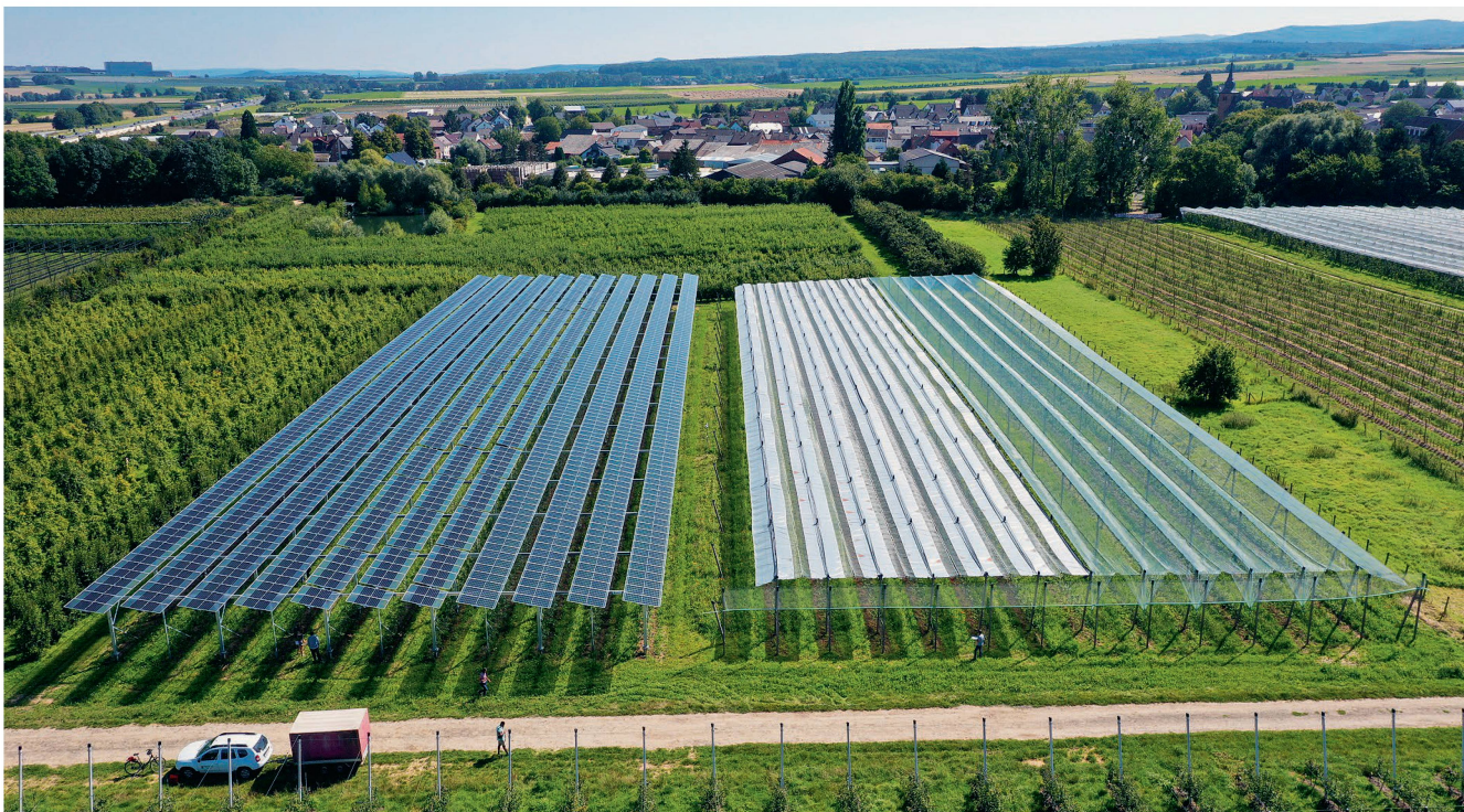
Installation photovoltaïque dans une culture fruitière à Gelders, en Rhénanie allemande. La production de ce type d'électricité offre aux agriculteurs une nouvelle source de revenus. Les modules solaires peuvent protéger les cultures mais en réduisent parfois le rendement.
