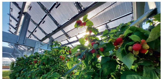
Fin juillet 2021, une installation pilote a été mise en service sur le site expérimental de l'Agroscope à Conthey (VS) pour mener des recherches agrivoltaïques. Les modules solaires produits par la jeune entreprise romande Insolight ont été spécialement conçus pour des applications agricoles. Ils sont partiellement transparents et l'incidence de la lumière peut être réglée entre 30 et 80%. De la sorte, l'ombre des plantes qui poussent en dessous peut être modulée. Photo: Agroscope
