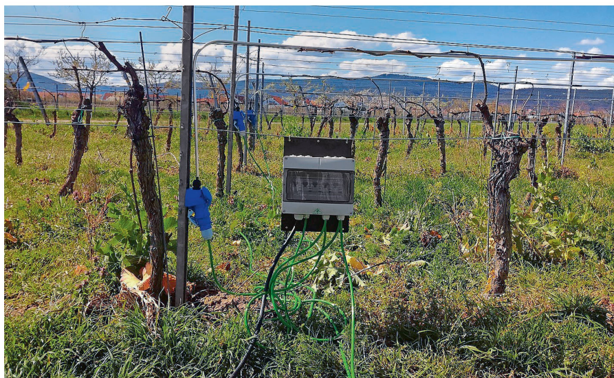
Des systèmes de câbles chauffants sont proposés depuis quelques années. Fonctionnant à l'électricité, ils s'installent le long des fils de palissage. Photo: Oliver Kurz DLR Rheinpfalz
