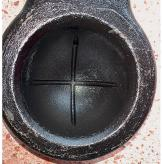
Deux exemples de calottes neuves avec rainures de lubrification en parfait état: photo de gauche, calotte Walterscheid, photo de droite, calotte Rockinger.
