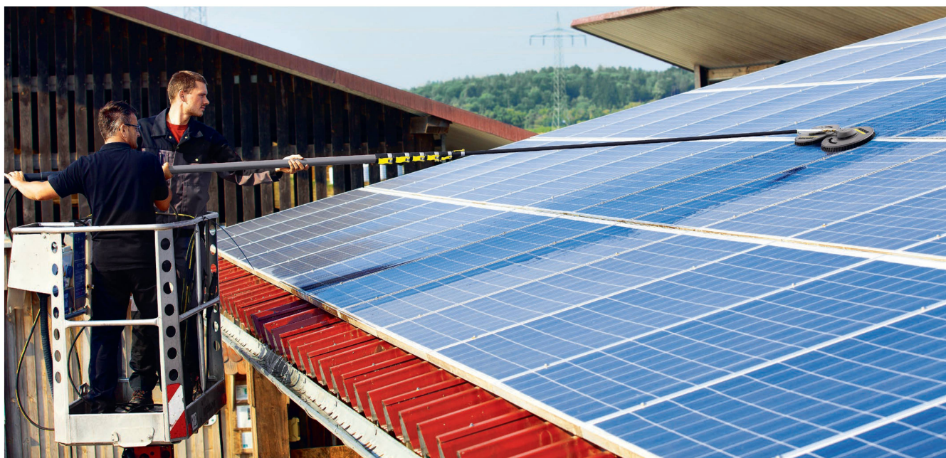
Les modules photovoltaïques ne peuvent fonctionner à plein régime que s'ils sont exempts de saleté et bien ensoleillés. Photo: Idd
