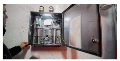
Le pilotage mécanique et les deux réserves de remèdes sont logés dans cette armoire.
