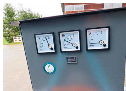
L'affichage analogique de la génératrice indique l'état de fonctionnement et le nombre d'heures de service.
