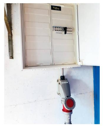
Le circuit de déconnexion est à faire monter par un professionnel. Il doit comprendre un interrupteur de mise à terre (en haut) et une prise compatible pour le raccordement du générateur (en bas).
