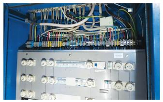
Si l'espace est trop restreint sur le tableau, il est nécessaire de prévoir une armoire de commande séparée, parce que les câbles nécessaires aux branchements sont très épais.
