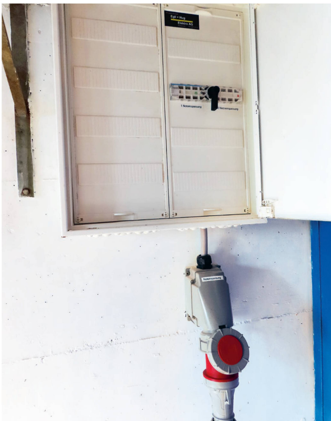
Le circuit de déconnexion est à faire monter par un professionnel. Il doit comprendre un interrupteur de mise à terre (en haut) et une prise compatible pour le raccordement du générateur (en bas).
