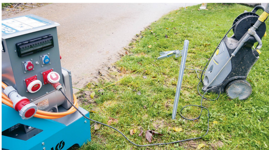
Le piquet de terre est enfoncé le plus profondément possible dans le sol humide et raccordé au câble de mise à la terre.
