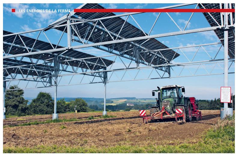
Double récolte, d'énergie solaire en haut et de produits de la culture en bas. Les panneaux sont montés à une hauteur parfaite: l'ombrage est modéré et les machines peuvent passer en dessous. En outre, l'écartement des poteaux ne gêne pas trop leur circulation. Photo: Tommsdorff
