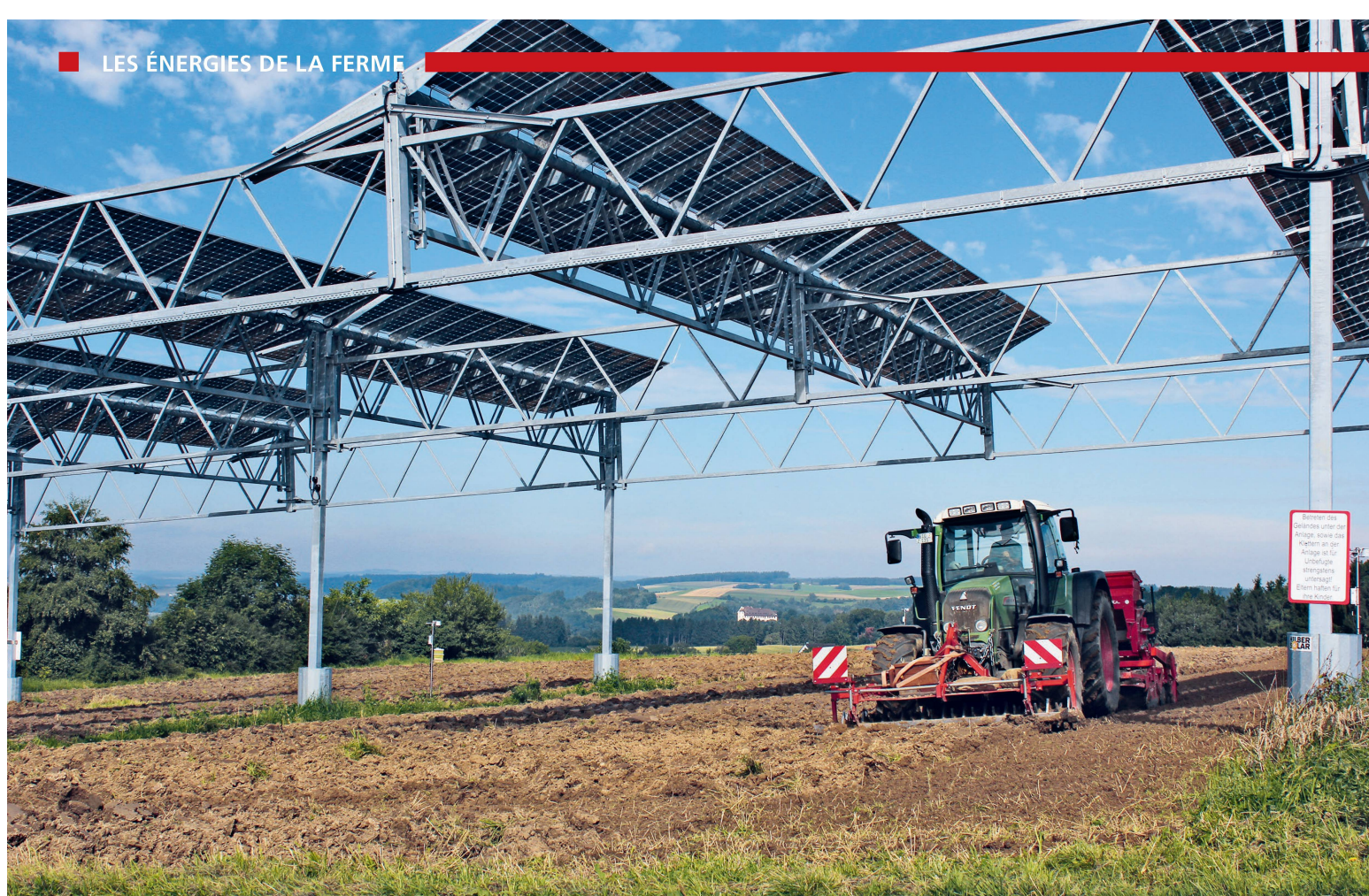
Double récolte, d'énergie solaire en haut et de produits de la culture en bas. Les panneaux sont montés à une hauteur parfaite: l'ombrage est modéré et les machines peuvent passer en dessous. En outre, l'écartement des poteaux ne gêne pas trop leur circulation. Photo: Tommsdorff
