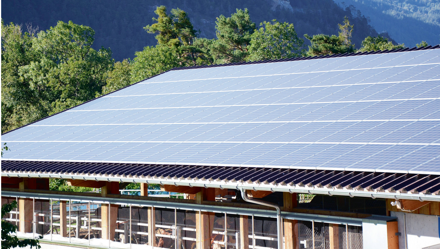
Les installations photovoltaïques n'utilisent qu'une partie de l'énergie solaire pour la production d'électricité. Il est ainsi possible d'utiliser la chaleur résiduelle pour le séchage en grange. Photo: Ruedi Hunger
