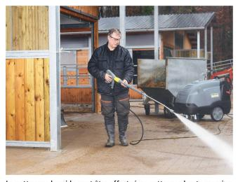
Le nettoyage humide peut être effectué au nettoyeur haute pression à eau froide ou chaude.
