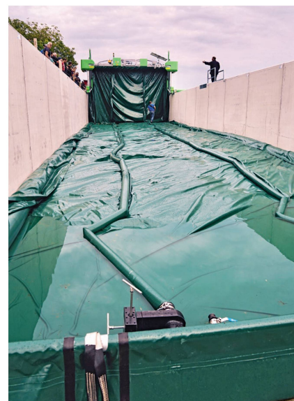
La bâche se déploie en 15 minutes sur les 40 mètres de longueur du silo-couloir.
