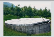
Eléments creux en béton précontraint
