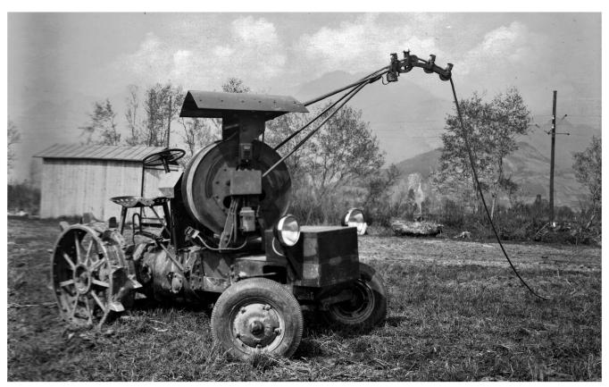
Il y a tout juste 80 ans, en 1941, les Ateliers de constructions mécaniques de Vevey (ACMV) proposaient ce qui devait être le premier tracteur électrique au monde. Ici la version construite sur la base d'un châssis Allis-Chalmers avec sa prise de courant à droite sur la ligne électrique, le tambour d'enroulement pivotant avec sa potence. Sous cet élément se trouve le boîtier du moteur d'entraînement du tambour, et à gauche les deux entraînements du tracteur. Photos: Archives Franz Morgenegg
