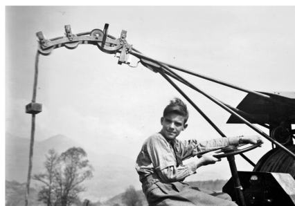
La potence, ses quatre roues de guidage, ses roulettes de maintien et la butée du contacteur. La potence est toujours orientée dans le sens de marche.
