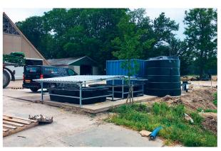
Les systèmes de traitement biologique, tels «Biobed», «Biopac» (en photo), utilisent l'évaporation de l'eau et la dégradation des résidus de phytos par des microorganismes. Photo: Biopac
