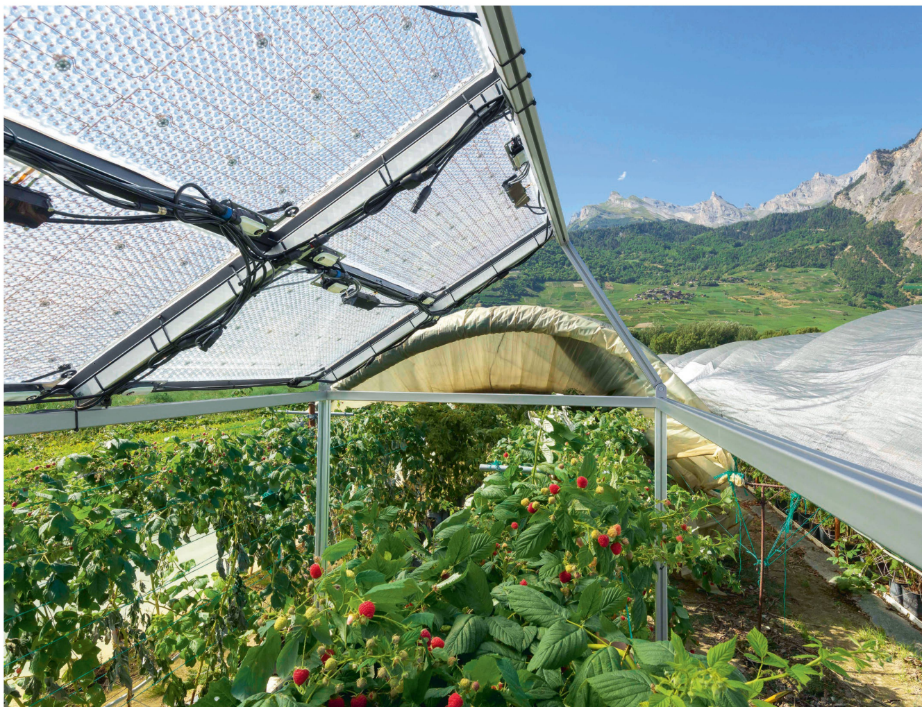
La start-up lausannoise Insolight vise le marché agrophotovoltaïque. Exemple d'installation agrivoltaïque où les modules «Theia» remplacent les tunnels de protection en plastique généralement utilisés pour protéger les cultures de baies. Photo et schémas: Insolight
