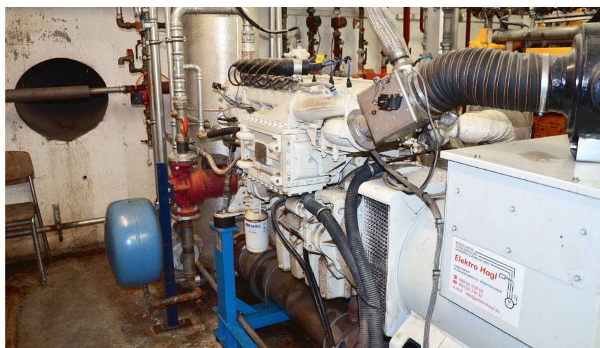
L'unité de cogénération remplacée à la suite d'un agrandissement d'installation peut continuer à être utilisée comme unité annexe ou de réserve.
