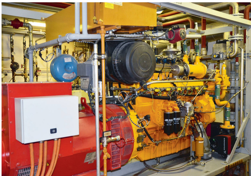
L'unité de cogénération est souvent considérée comme le cœur d'une installation de biogaz.
