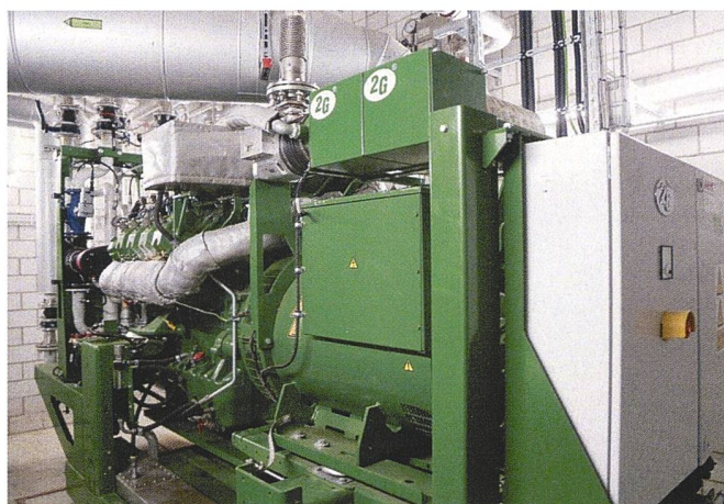
Le moteur carburant au gaz de bois, d'une puissance de 240 kW, a produit au cours de son premier mois d'utilisation l'équivalent de l'électricité consommée en un an par près de 30 ménages suisses.
