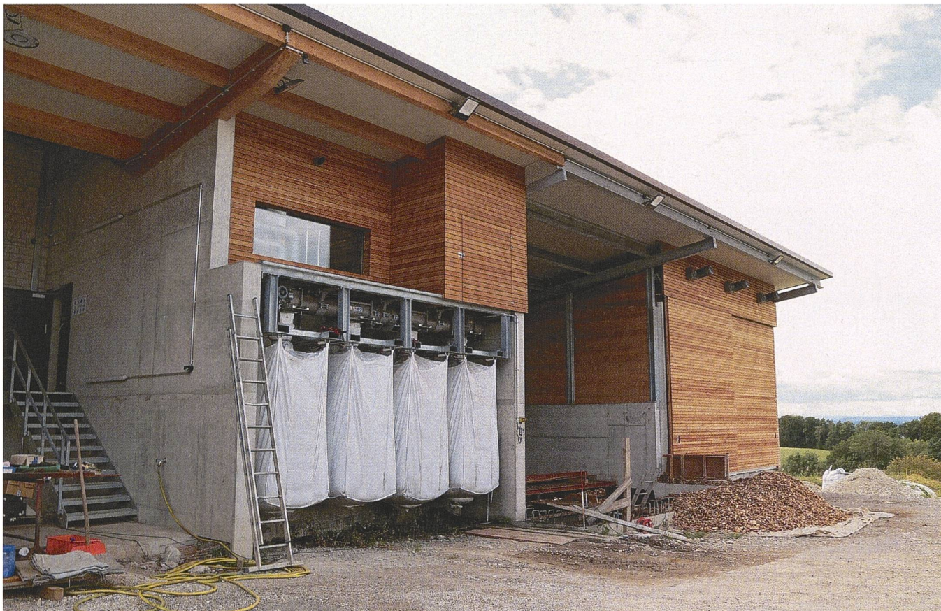
L'installation de gazéification de bois à Desibach (ZH). Une fois la production achevée, le charbon végétal est stocké dans des Big Bag.
