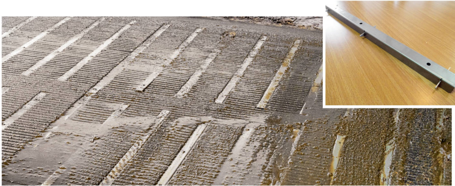
Les sols en caillebotis sont équipés de ce type de profilés en inox. Les excréments restent à la surface, tandis que l'urine s'écoule par les ouvertures vers une fosse souterraine.
