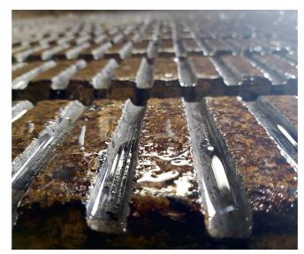
Le rotor de rainurage des caillebotis, composé de 60 disques diamant, forme une coupe nette pour des rainures de 4 à 5 mm de profondeur et 12 mm de largeur. Photo: Jossi Farm Equipement
