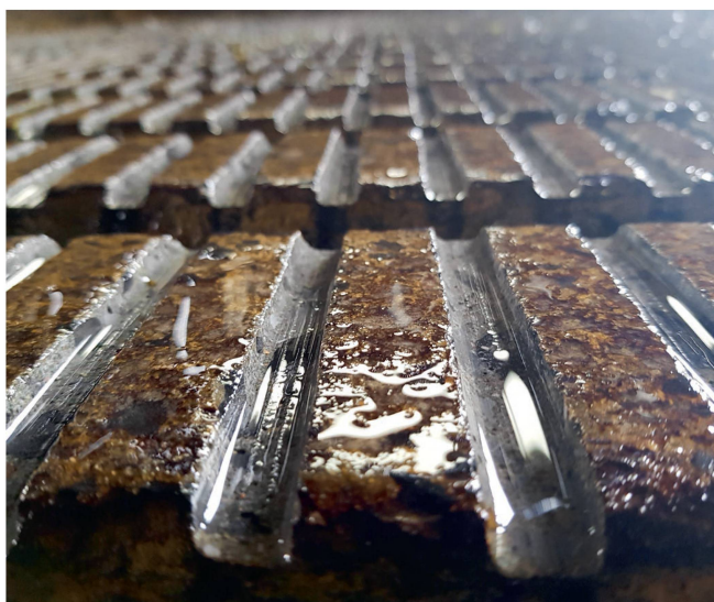
Le rotor de rainurage des caillebotis, composé de 60 disques diamant, forme une coupe nette pour des rainures de 4 à 5 mm de profondeur et 12 mm de largeur. Photo: Jossi Farm Equipment
