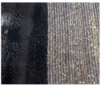
Pratiquée exclusivement sur béton plein, la scarification (à droite) forme de petites stries de 3 à 4 mm de profondeur. Photo: Jossi Farm Equipement
