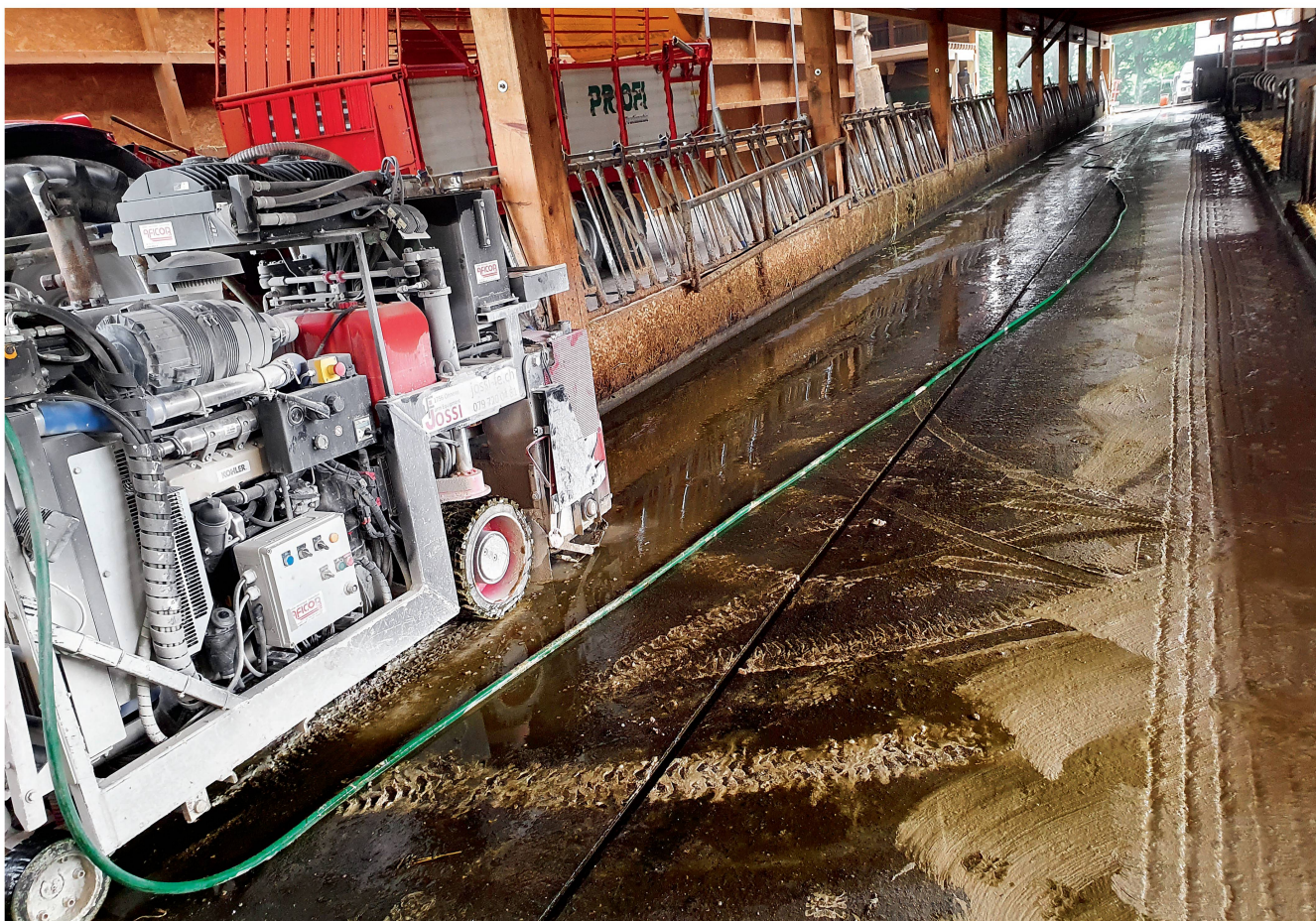
Le débit d'un chantier de rainurage ou de scarification oscille entre 500 et 550 m 2 /jour selon la configuration des lieux et avec l'aide du client.
