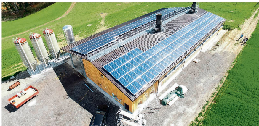
Le poulailler Micarna, à Hellsau (BE): Les deux échangeurs de chaleur tubulaires s'aperçoivent entre les modules photovoltaïques et l'accumulateur de chaleur à gauche, à côté du silo à fourrage. On a posé 2800 mètres de conduites de saumure pour la pompe à chaleur. Photo: OFEN
