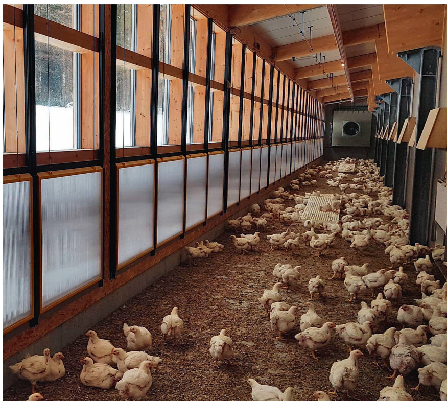
Poulailler à Zimmerwald (BE): le jardin d'hiver est fermé lorsque les températures sont basses. Il est perpétuellement alimenté en air frais et préchauffé au moyen de l'échangeur de chaleur visible tout au fond. Photo: Exploitation Guggisberg et Nussbaum (BZG)
