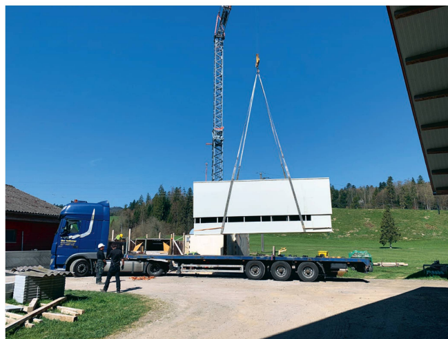
Un laveur d'air biologique est amené par la société Jenni à son emplacement définitif dans un conteneur préfabriqué.
