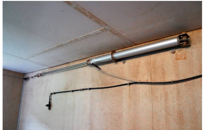
Le vérin maintient les fenêtres fermées au moyen d'un câble.
