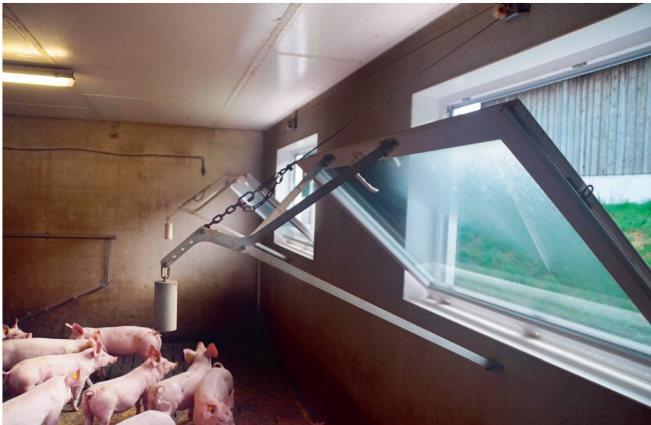
Des poids fixés aux câbles tirent les fenêtres à soufflet vers le bas.
