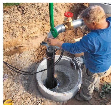
Rolf Kuhn vient d'installer une pompe immergée neuve dans ce puits de 13 mètres de profondeur.
