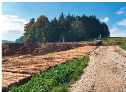
Aménagement d'un dépôt de terre végétale en vue de sa réutilisation future.
