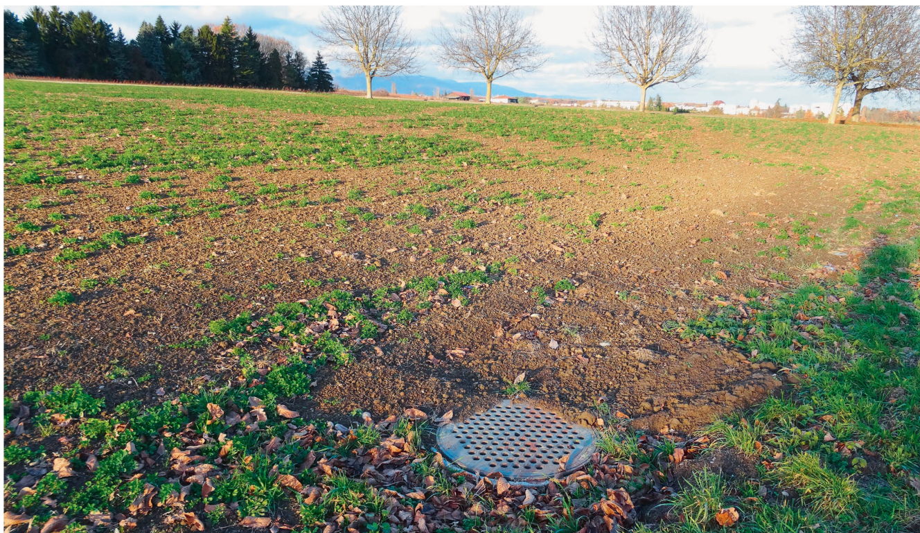
De l'avis des responsables des offices cantonaux de protection de l'environnement, les agriculteurs dont les champs contiennent des puits sans couvercles, comme sur cette photo, doivent contacter l'opérateur de la canalisation et chercher à remédier à ce défaut. Photos : Eawag, Urs Schönenberger
