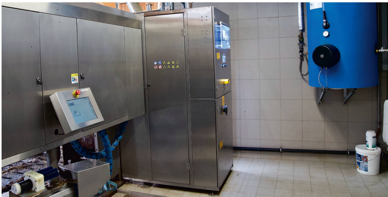
L'énergie excédentaire fournie par l'installation photovoltaïque (ou les éoliennes) est utilisée pour préparer de l'eau bouillante pour l'installation de traite Lemmer-Fullwood dans l'exploitation de Franz X. Demmel, à Schönrain, lieu-dit situé près du village bavarois de Königsdorf.
