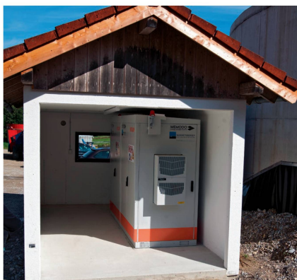
Le système de batterie lithium-ion sert de solution globale pour le stockage d'énergie stationnaire à la ferme du Huabahof.
