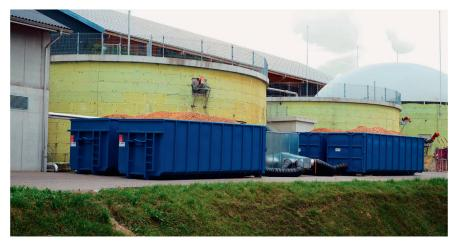
Séchage de bois en conteneurs utilisant la chaleur résiduelle de l'installation de méthanisation à l'arrière-plan.
