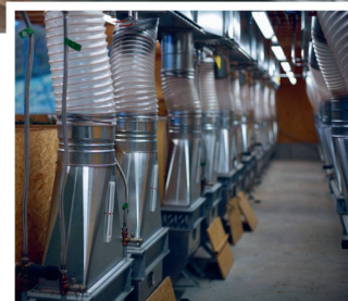
Installation de séchage de semence à échangeur de chaleur.
