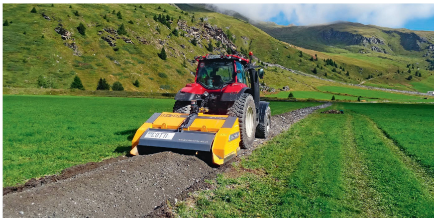
Selon l'état du chemin, l'intervention d'un défonceur suivi d'un concasseur et d'un tassement au moyen de plaques vibrantes peut être nécessaire. Photo : Cotti
