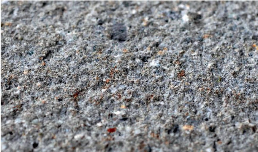
Procédé d'assainissement par jet d'eau haute pression avec abrasifs de 0,6 à 1 mm ; il faut décoller entièrement les couches calcaires pour obtenir le résultat recherché.
