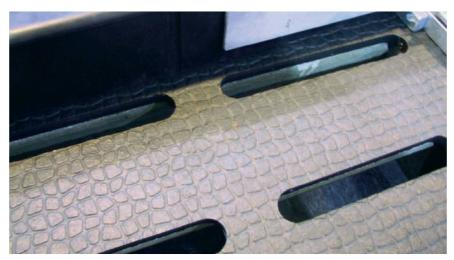
La perforation du revêtement élastique en caoutchouc doit être parfaitement adaptée au caillebotis. Il est indispensable d'adapter la technique d'évacuation du fumier.
