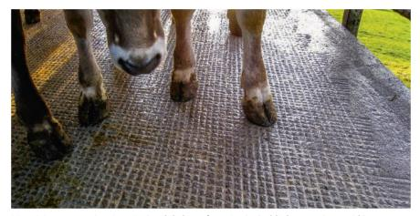
L'assainissement mécanique intégral de la surface vise à rétablir le caractère antidérapant. Afin de garantir une démarche sûre, il est nécessaire dans le sens longitudinal et transversal, ce qui requiert un traitement dans les deux sens dans le cas du rainurage.
