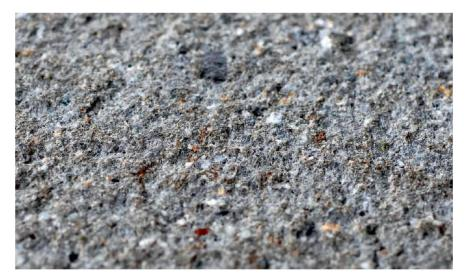
Procédé d'assainissement par jet d'eau haute pression avec abrasifs de 0,6 à 1 mm; il faut décoller entièrement les couches calcaires pour obtenir le résultat recherché.
