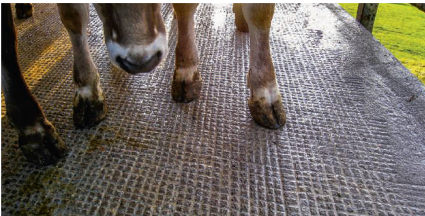
L'assainissement mécanique intégral de la surface vise à rétablir le caractère antidérapant. Afin de garantir une démarche sûre, il est nécessaire dans le sens longitudinal et transversal, ce qui requiert un traitement dans les deux sens dans le cas du rainurage.
