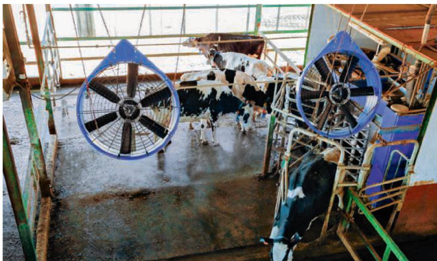
Les ventilateurs d'appoint sont à monter avec une inclinaison de 12 à 15°. Photo : DeLaval
