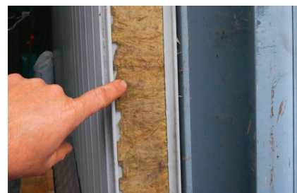
Des panneaux « sandwich » avec une isolation en laine de pierre utilisés pour l'habillage d'un atelier apportent simplicité d'entretien et protection incendie.
