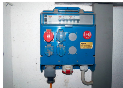
L'installation d'un tableau électrique de chantier permet une alimentation simple avec l'ensemble des disjoncteurs FI et sécurités nécessaires.
