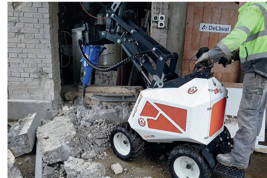
L'hydraulique dispose d'un refroidissement assez performant pour une utilisation en continu d'outils exigeants.
