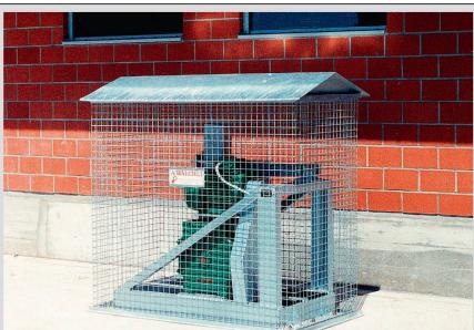
Le grillage entourant complètement un brasseur de lisier fixe empêche tout accès aux parties mobiles de la machine. Après utilisation ou réparation du brasseur, la protection doit impérativement être remise en place. Lors du brassage, les gaz peuvent s'échapper par la petite ouverture nécessaire au fonctionnement.
