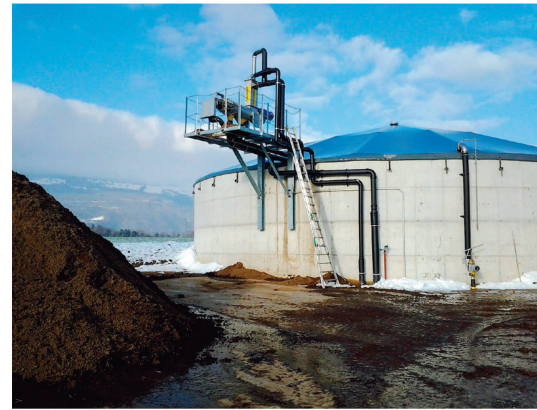
Il y a tout à gagner à installer sur une plateforme les séparateurs avec conduite de trop-plein, pour qu'ils surplombent la fosse.
