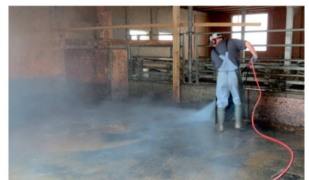
Une rotabuse dotée d'une puissance suffisante permet d'enlever le calcaire et les dépôts des caillebotis.
