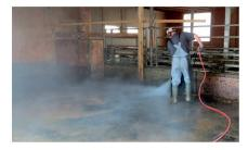
Une rotabuse dotée d'une puissance suffisante permet d'enlever le calcaire et les dépôts des caillebotis.
