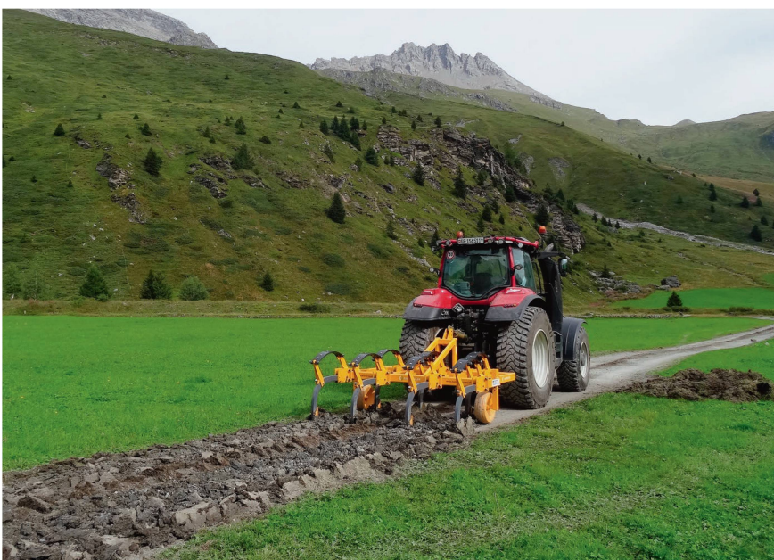
Avant le traitement avec l'extirpateur de pierres, un premier passage avec un broyeur lourd est effectué sur la route non asphaltée pour ouvrir le sol à la profondeur nécessaire.
