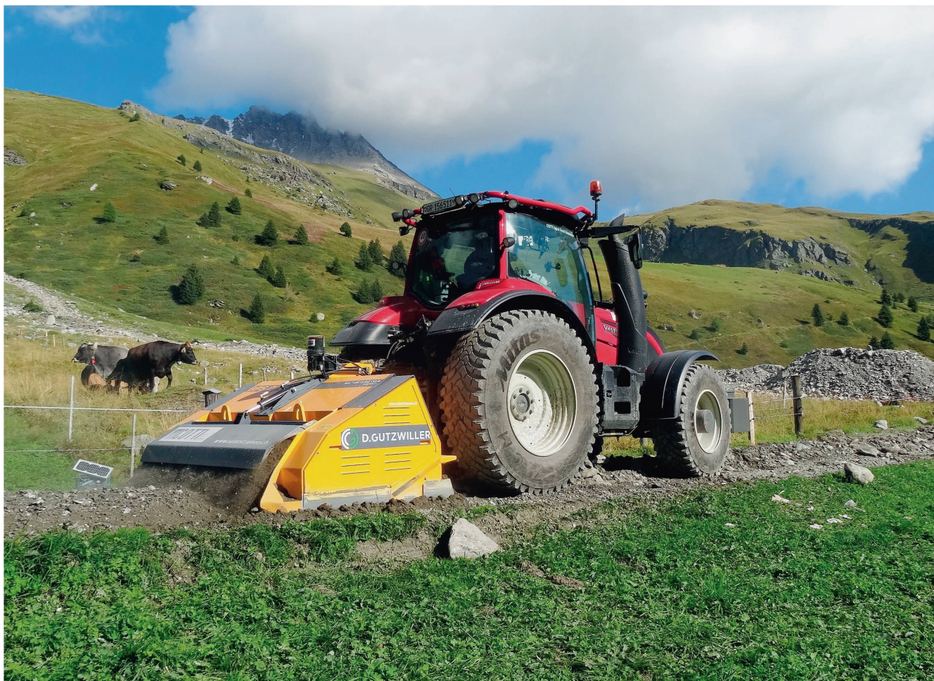
L'entreprise de Pirmin Cotti est spécialisée dans la construction et l'entretien de routes non asphaltées. Le tracteur est attelé ici avec un broyeur de pierres. Photos: Pirmin Cotti
