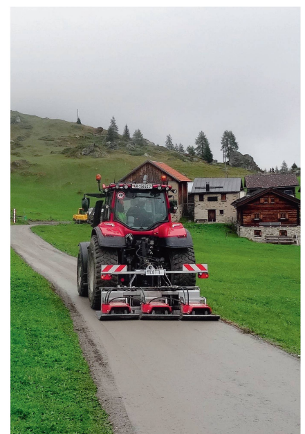
Le travail s'achève avec une triple plaque vibrante.
