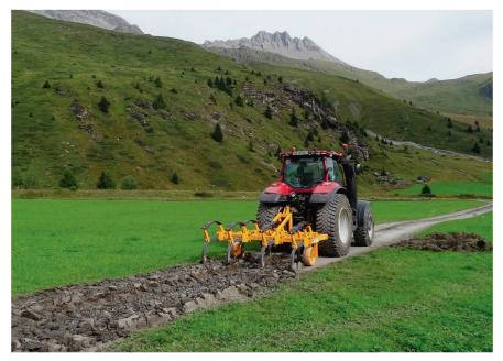
Avant le traitement avec l'extirpateur de pierres, un premier passage avec un broyeur lourd est effectué sur la route non asphaltée pour ouvrir le sol à la profondeur nécessaire.
